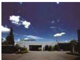
本社 （静岡県浜松市浜北区）
